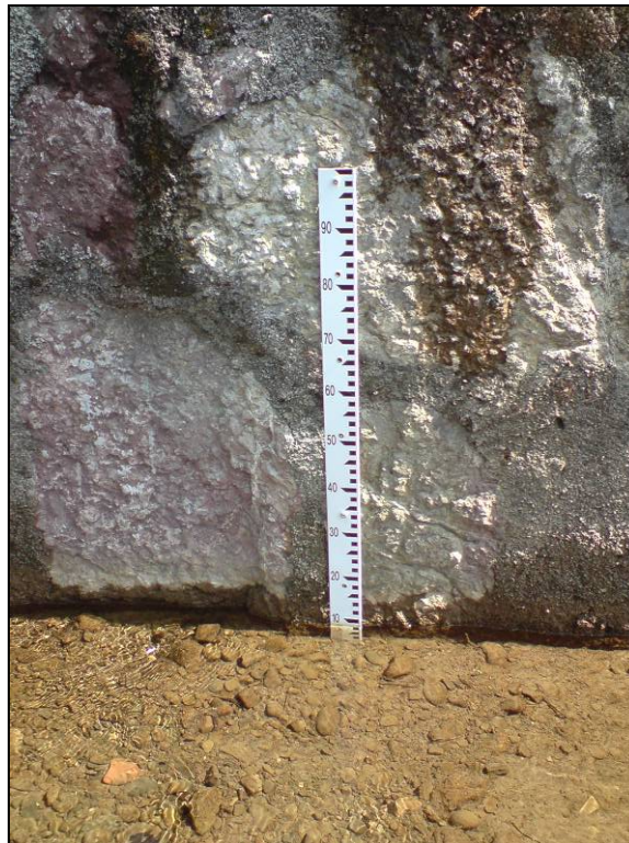
Fotografía 10-4.- Escala limnimétrica anclada a la pared del cauce en la sección de aforo del río San Juan
