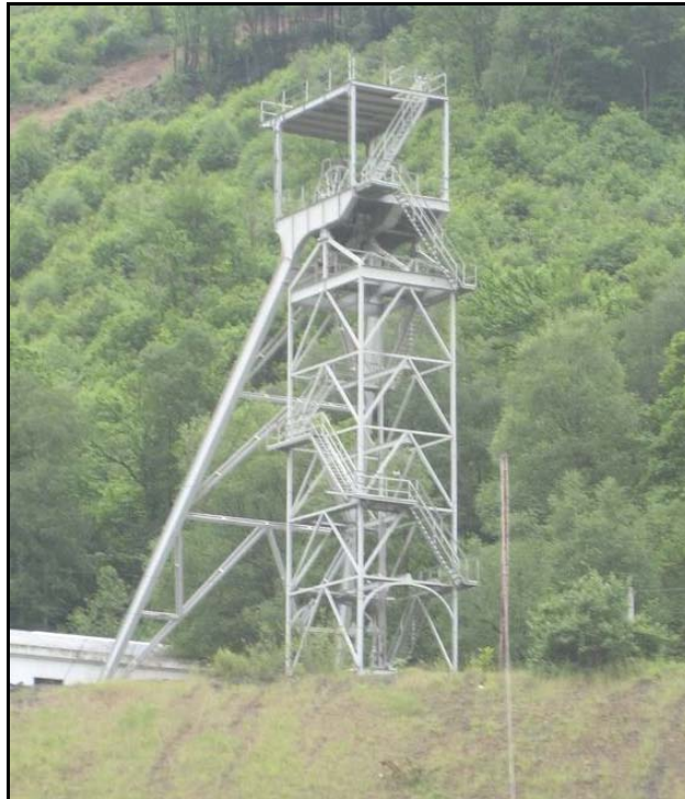
Fotografía 6-3.- Vista del Pozo Tres Amigos
