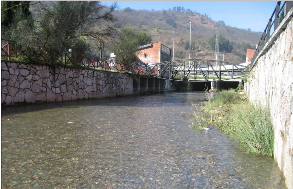
Fotografía 10-3.- Sección de aforo en el río San Juan
